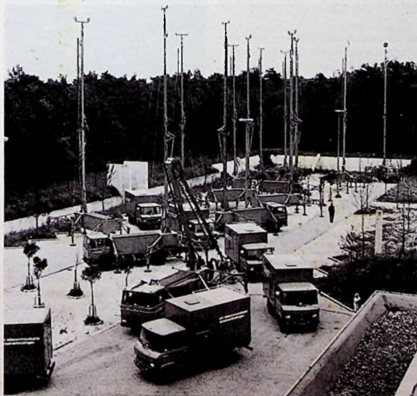
'Vlootshow' van de nieuwe uitrusting (apparaatwagens en zendmasten) op het terrein van het bijna afgebouwde Audio-videoverbindingencentrum van de PTT in Hilversum.
